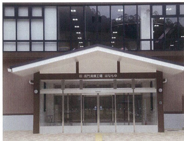
清掃工場 管理棟 玄関
